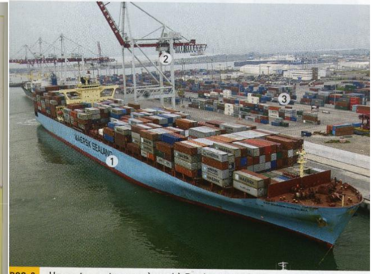
DOC. 3 Un porte-conteneurs à quai à Dunkerque. 1. porte-conteneurs - 2. portiques - 3. zone de stockage des conteneurs
